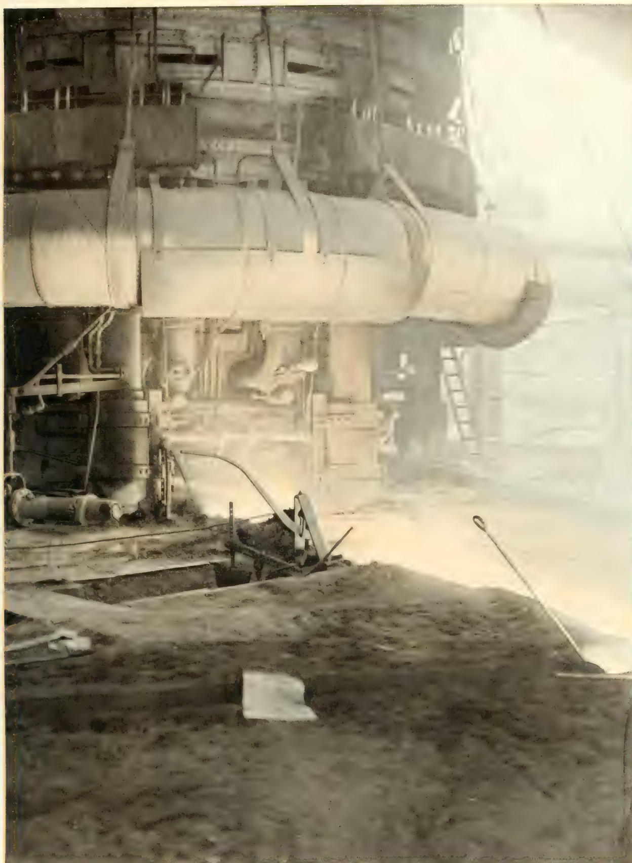
UNE COULÉE DE FONTE. — Par l'ouverture béante du haut fourneau, le métal en fusion s'échappe en bouillons incandescents et s'écoule dans les poches mobiles qui vont ensuite les déverser dans les lingotières.
